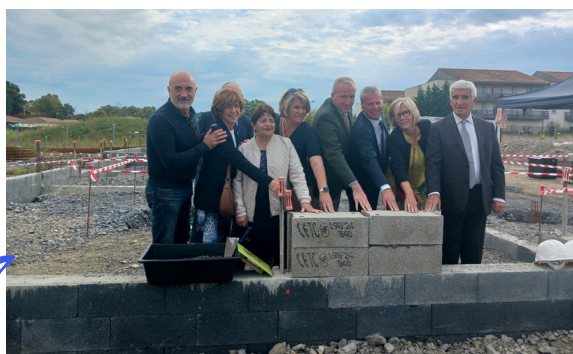
Pose de la première pierre
